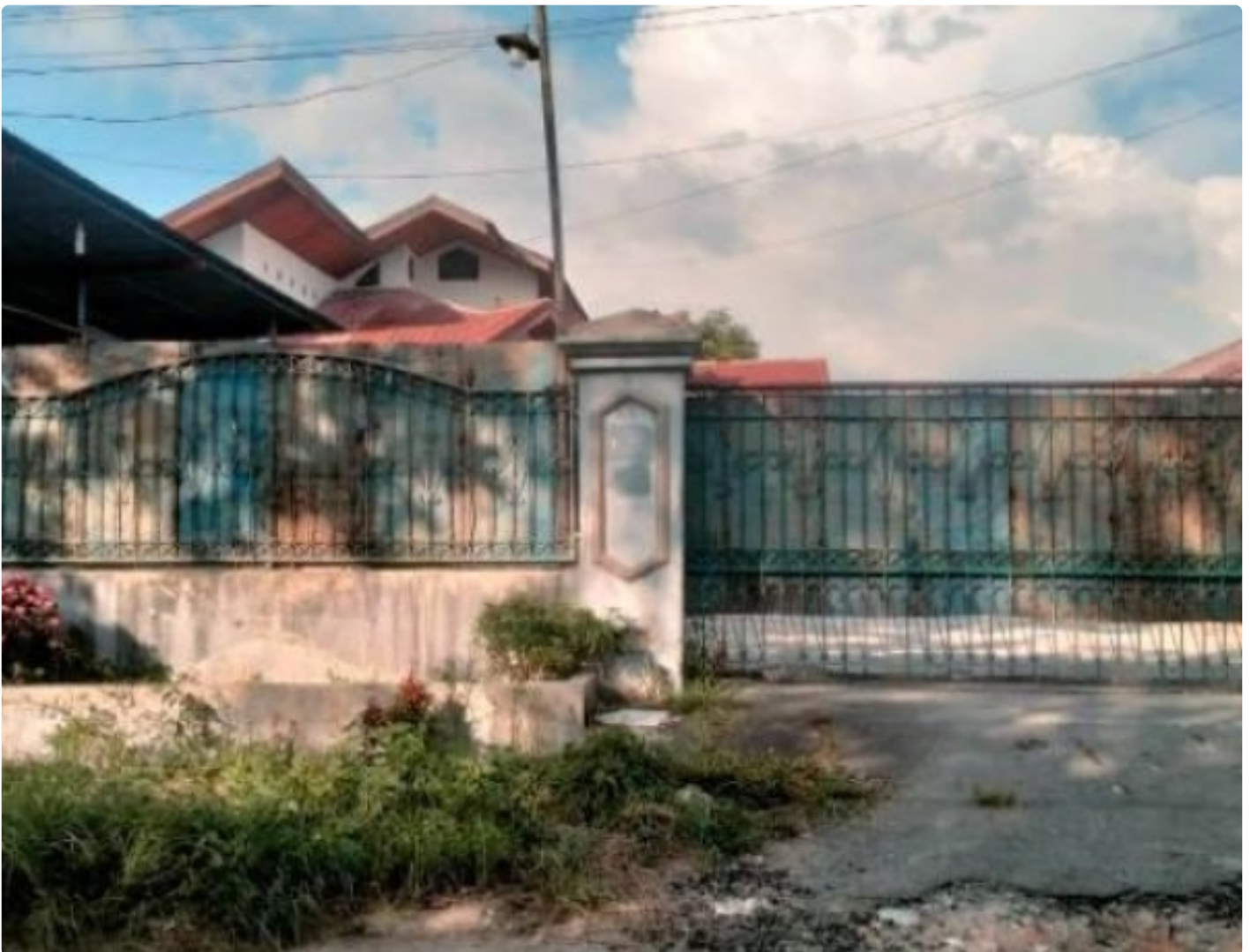
Gudang Isi Ulang Gas Medis (Oksigen) 'Siluman' di lingkungan Kantor Dinas Kesehatan Pemkab Karo yang tampak tertutup
